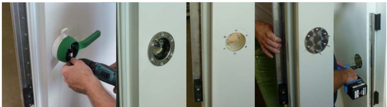
5. Bestehender Griff entfernen, Bohrung ausschäumen und Abdeckung montieren
