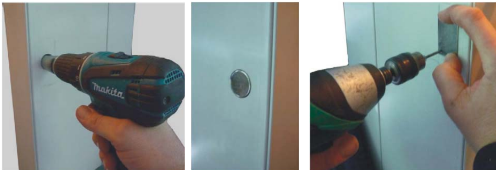
Oder Magnet in Türstock versenkt montieren (Variante 2)
