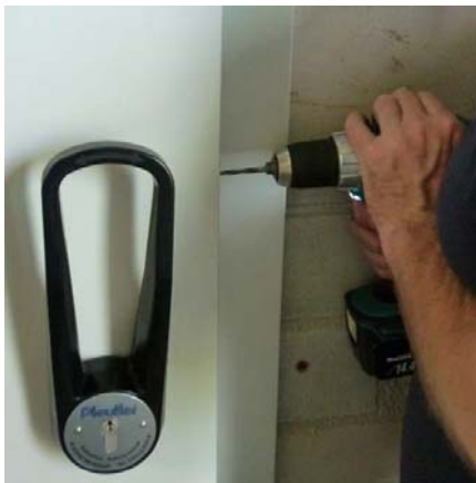
2. Nietlöcher bohren
