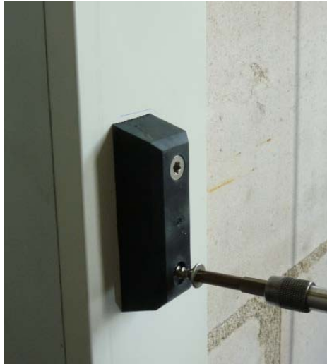
4. Gegenmagneten montieren (Variante 1)
